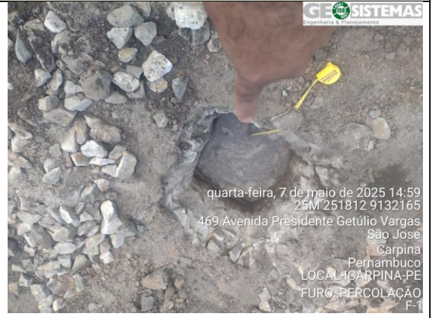
Foto 2 – Execução do ensaio de Percolação Furo 1.
