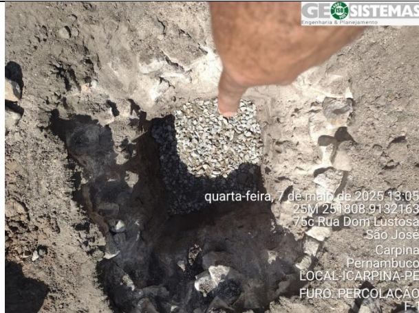
Foto 3 – Execução do ensaio de Percolação Furo 1.
