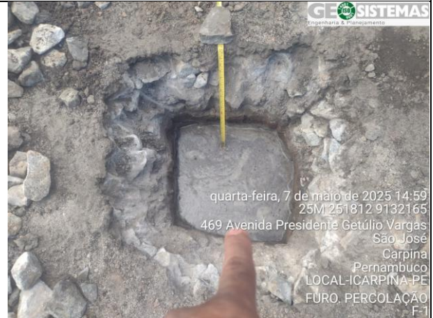
Foto 4 – Execução do ensaio de Percolação Furo 1.
