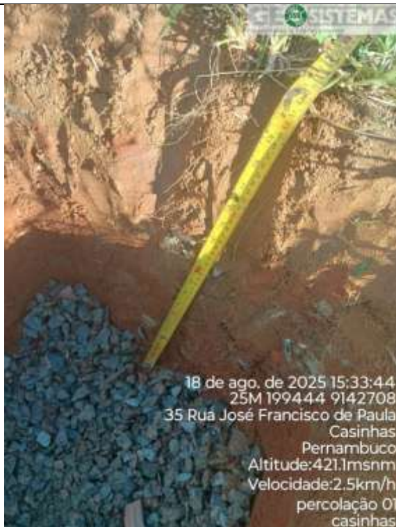
Foto 3 – Execução do ensaio de Percolação Furo 1.
