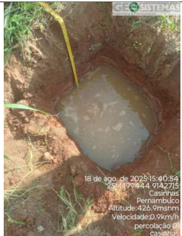
Foto 4 – Execução do ensaio de Percolação Furo 1.
