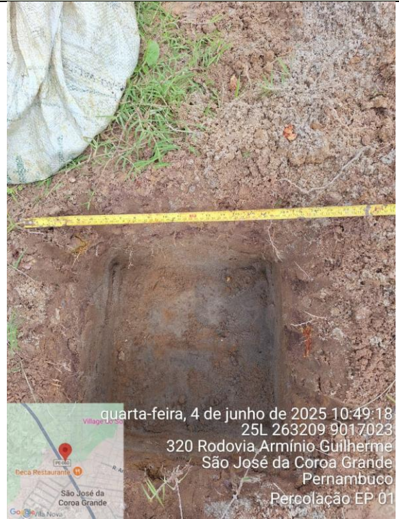
Foto 2 – Execução do ensaio de Percolação Furo 1.
