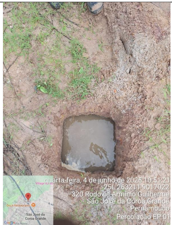
Foto 4 – Execução do ensaio de Percolação Furo 1.
