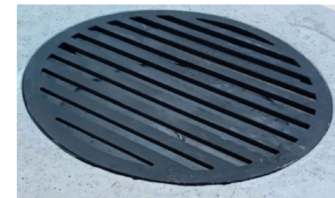
TAMPA REDONDA EM FERRO FUNDIDO DN 0,60 TRÁFEGO: CARROS COMERCIAIS E VIATURAS - NBR-10160:2005/BS EN 124-2
