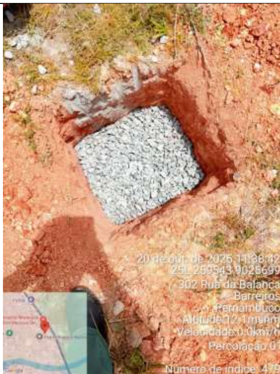
Foto 3 – Execução do ensaio de Percolação Furo 1.
