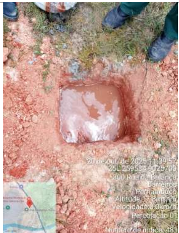
Foto 4 – Execução do ensaio de Percolação Furo 1.
