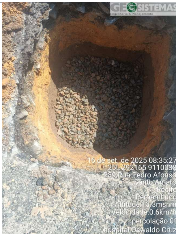
Foto 3 – Execução do ensaio de Percolação Furo 1.
