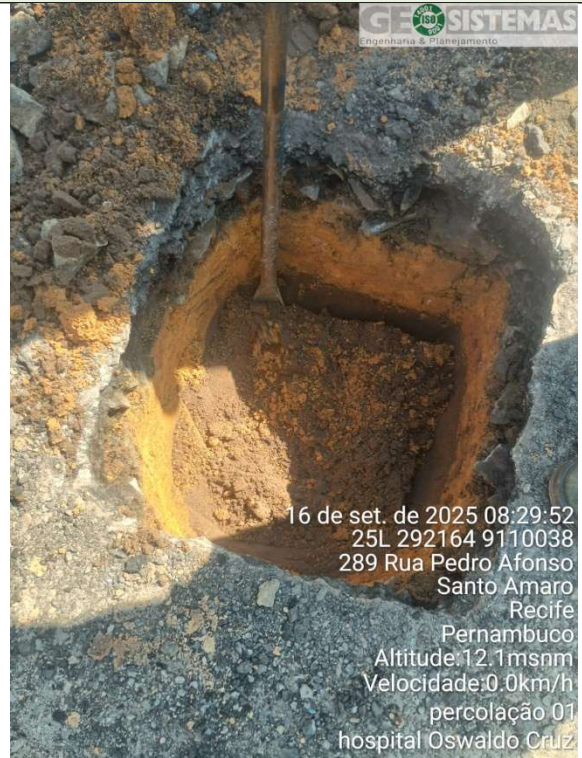
Foto 2 – Execução do ensaio de Percolação Furo 1.
