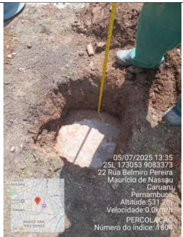
Foto 4 – Execução do ensaio de Percolação Furo 1.
