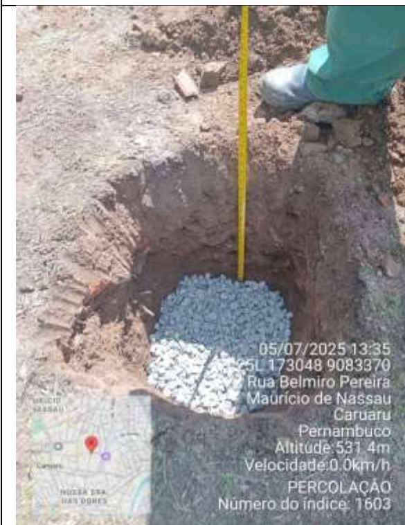
Foto 3 – Execução do ensaio de Percolação Furo 1.
